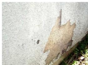
◆塗装が剥がれている箇所から雨水が浸み込み雨漏りの原因になります！！
